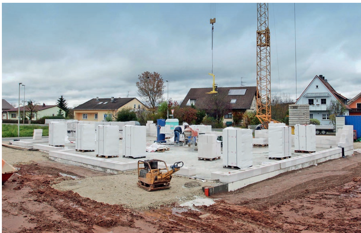
Baustelle Mehrfamilien- haus aus Porenbeton, Frensdorf
