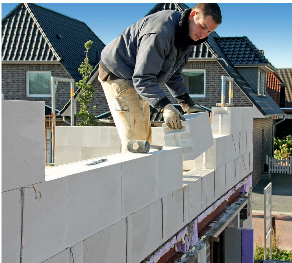
Die erste Lage entscheidet über die Pass- genauigkeit der Wand.
