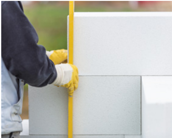
Abb. 3.4: Erstellung nahezu fugenloser, planebener Wandoberflächen
