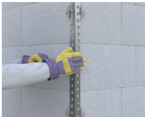
Abb. 10.23: Sicherung der senkrechten Gebäudekanten durch Eckschutzprofile
