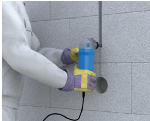
Abb. 10.20 (links): Auskratzen von Leitungsschlitzten mit einem Schlitzkratzer
