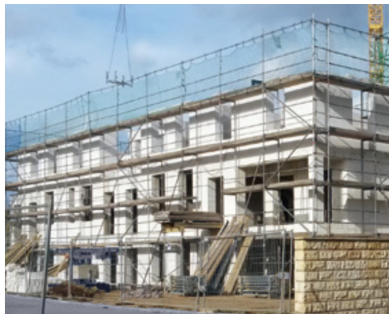
Abb. 3.1 und 3.2: Erstellung von monolithischen (einschaligen) Außenwänden aus massivem, tragendem Porenbetonmauerwerk
