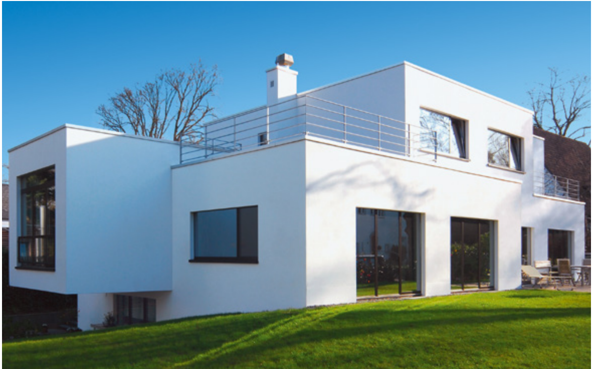
Abb. 11.6 und 11.7: Einfamilienhaus in Hamburg
