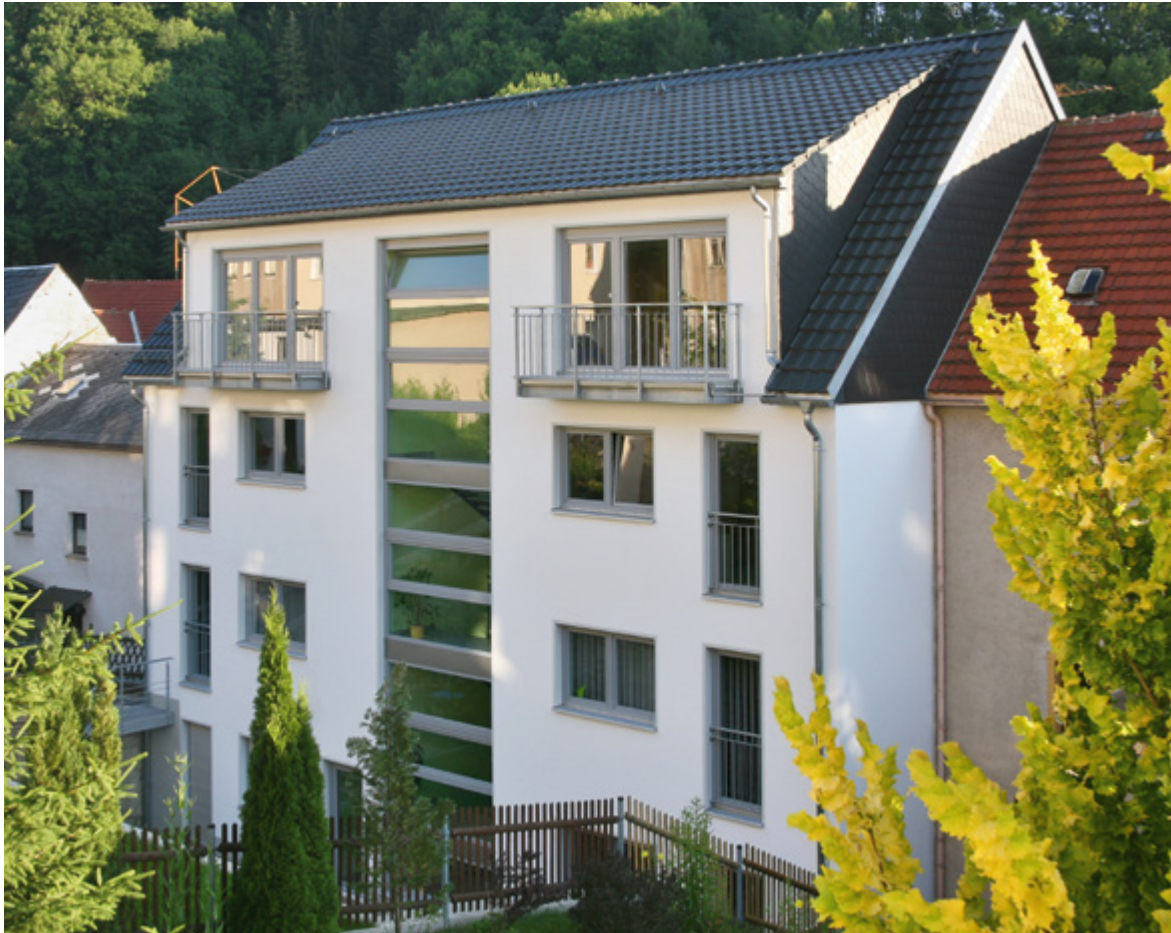
Abb. 11.26 und 11.27: Bestandsersatz – Neu- bau Büro- und Wohn- gebäude in Glashütte
