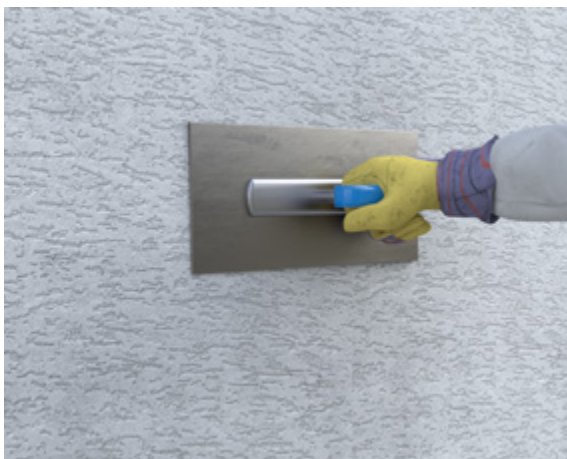
Abb. 10.26: Einlagiger Leichtputz als Außenputz auf Porenbetonmauerwerk – Aufbringen der zweiten Schicht und Strukturieren der Oberfläche
