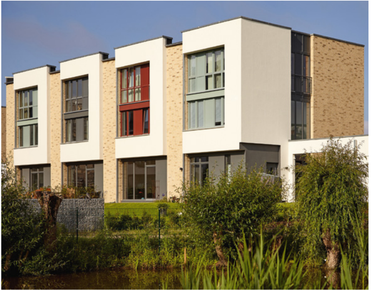
Abb. 11.14: „Am Schwanenteich“ im Wohnquartier Wai- sengärten in Schwerin/ Reihenhäuser mit Außenwänden aus Porenbetonmauerwerk
