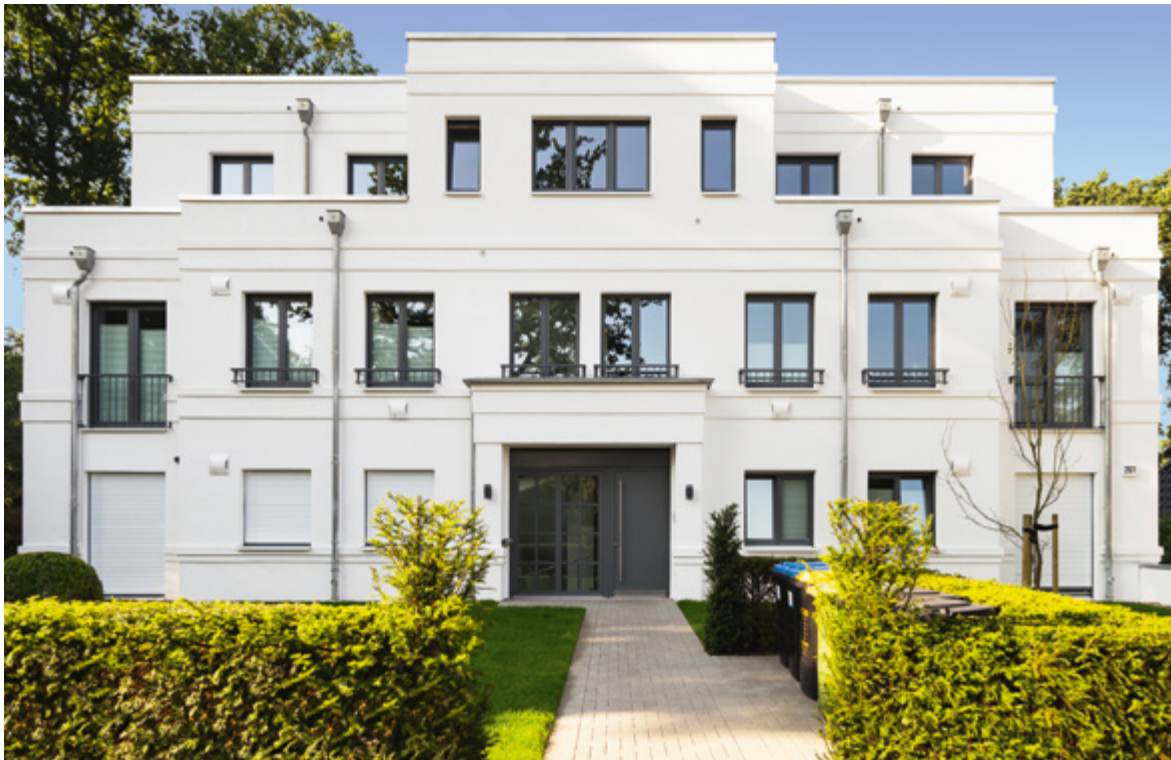
Abb. 11.18, 11.19 und 11.20: 3-geschossiges Mehrfamilienhaus mit Außenwänden aus Porenbetonmauerwerk in Hamburg
