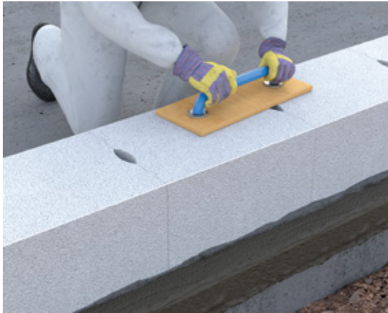
Abb. 10.6: Beseitigen von ausführungsbedingten Unebenheiten mit einem Schleifbrett
