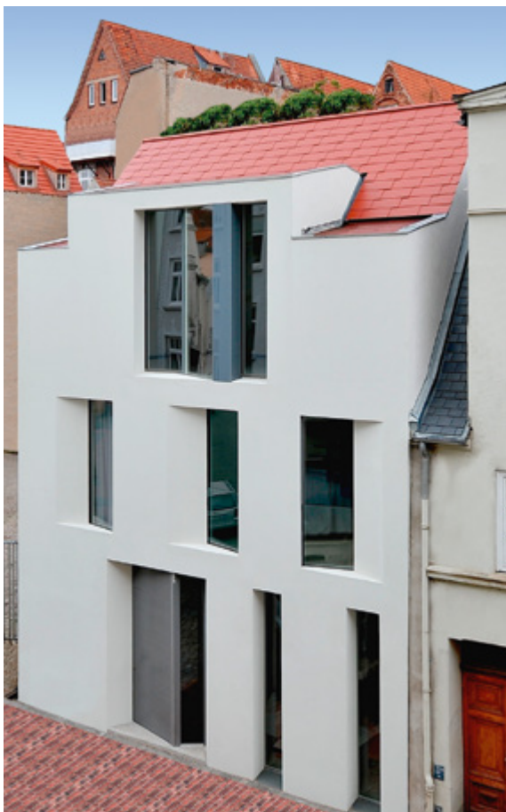
Abb. 11.28, 11.29 und 11.30: Bestands- ersatz – Neubau Wohnhaus in Lübeck
