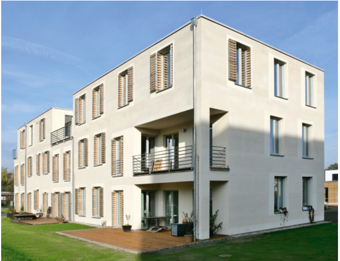
Abb. 11.16 und 11.17: 3-geschossiges Mehrfamilienhaus mit Außenwänden aus Porenbetonmauerwerk in Dresden
