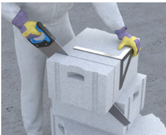
Abb. 10.17: Herstellung von Passtücken mit einer Handsäge
