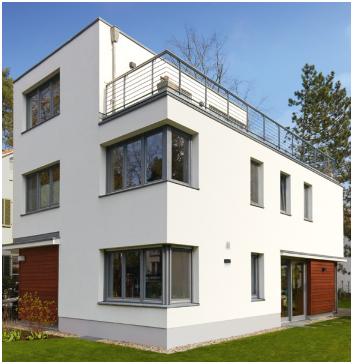
Abb. 11.8 und 11.9: Einfamilienhaus in Berlin
