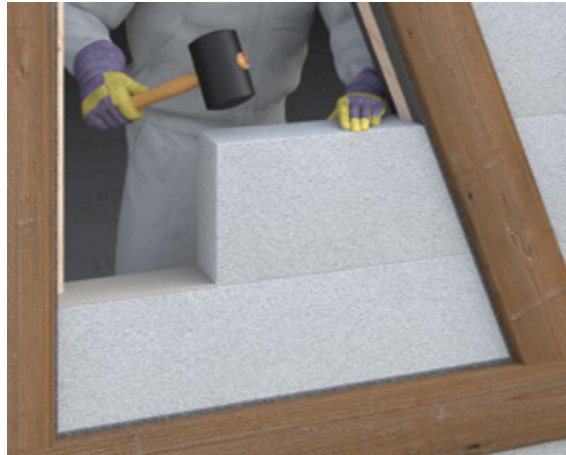
Abb. 10.27: Ausmauerung von Holzfachwerk mit Porenbeton
