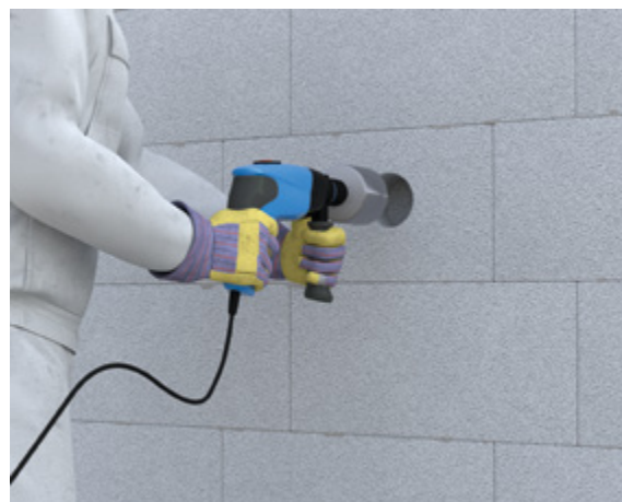
Abb. 10.19: Bohren von Aussparungen für Unterputzschalter und Verteilerdosen mit einem Steckdosenbohrer
