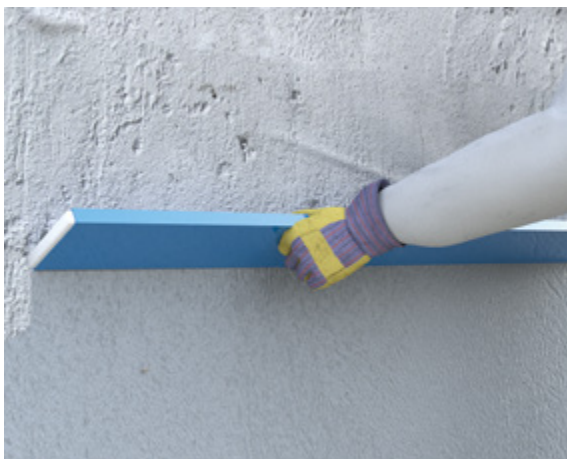
Abb. 10.25: Einlagiger Leichtputz als Außenputz auf Porenbetonmauerwerk – planebenes Abziehen mit einem Richtscheit
