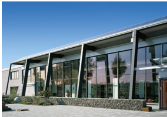
Abb. 11.34 und 11.35: Büro- und Ausstellungsgebäude, SCHULZ Systemtechnik GmbH in Visbek
