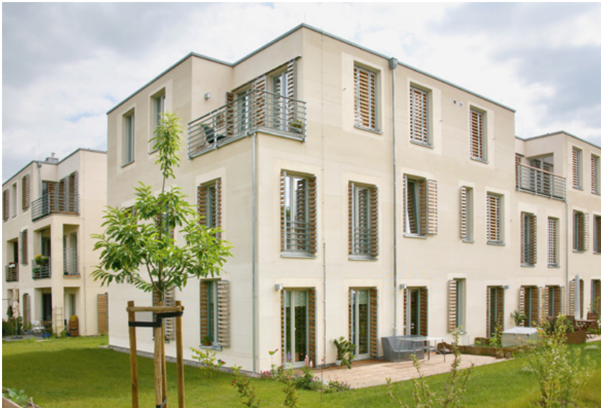
Abb. 11.15: Zwei 3-geschossige Mehrfamilienhäuser mit Außenwänden aus Porenbetonmauerwerk in Dresden
