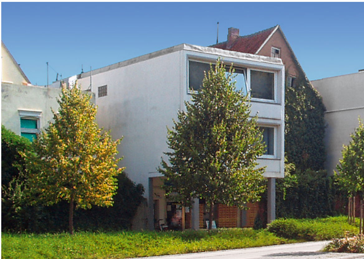
Abb. 11.31: Wohn- und Bürogebäude in Oldenburg vor der Aufstockung
