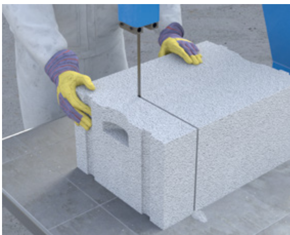
Abb. 10.18: Herstellung von Passtücken mit einer Bandsäge
