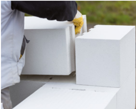
Abb. 3.3: Verlegung von Porenbeton-Plansteinen mit Nut-Feder-Profilierung und Griffhilfen im Dünnbettmörtelverfahren
