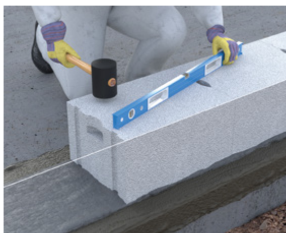
Abb. 10.5: Versetzen der Porenbeton-Plansteine und Ausrichten mit Gummihammer
